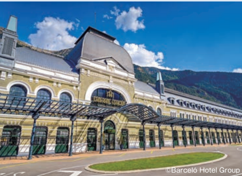
かつては建物自体が国境の役割を果たした国際駅を改装したホテル外観
